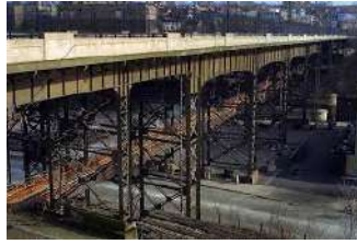
Şekil 25. Marsupial Köprüsü (URL-19)
