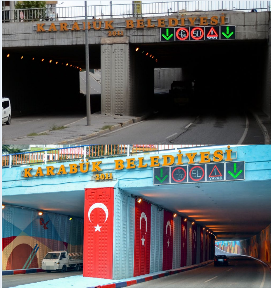
Görsel 3. Duvar Resmi 1’de tünel geçişi
