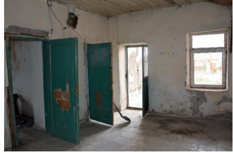
Fotoğraf 25: Taşdeğirmen Köyü İlkokul Binası Lojman Holü (B. Karacabey 2023).
