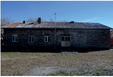
Fotoğraf 5: Börk Köyü İlkokul Binası Batı Cepheden Görünümü (B. Karacabey 2023).
