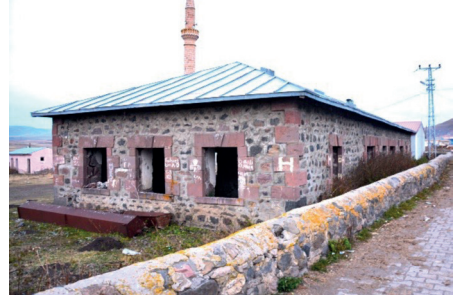
Fotoğraf 12: Çayağzı Köyü İlkokul Binası Güneybatıdan Görünümü (B. Karacabey 2023).
