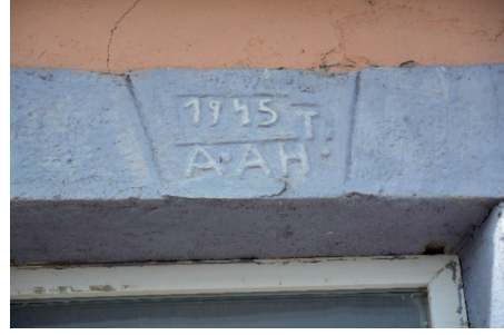
Fotoğraf 37: Sazlısu Köyü İlkokul İnşa Kitabesi (B. Karacabey 2023).
