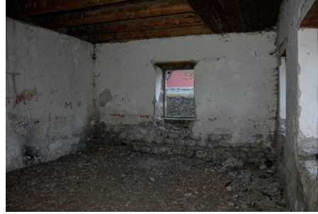
Fotoğraf 16: Çayağzı Köyü İlkokul Binası Sınıfı (B. Karacabey 2023).
