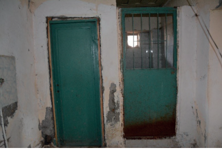
Fotoğraf 26: Taşdeğirmen Köyü İlkokul Binası Lojman Mutfağına Eklenen Bölümler (B. Karacabey 2023).
