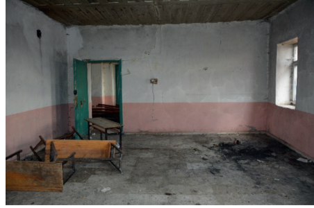
Fotoğraf 21: Taşdeğirmen Köyü İlkokul Binası 1 Nolu Sınıf (B. Karacabey 2023).
