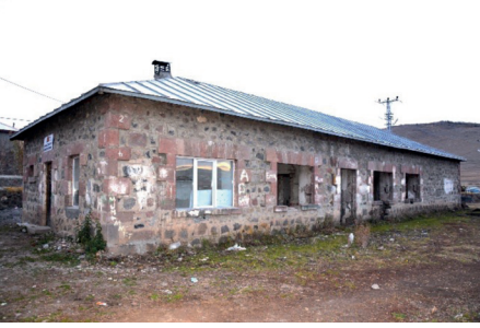
Fotoğraf 11: Çayağzı Köyü İlkokul Binası Kuzeydoğudan Görünümü (B. Karacabey 2023).
