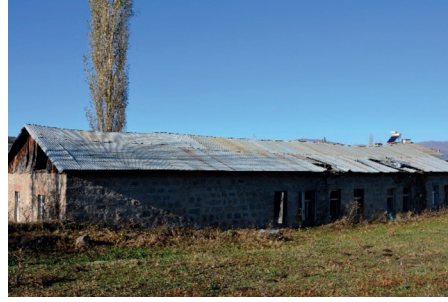
Fotoğraf 2: Asmakonak Köyü İlkokul Binası Doğu Cepheden Görünümü (B. Karacabey 2023).
