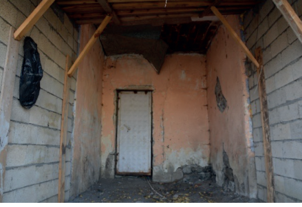
Fotoğraf 36: Sazlısu Köyü İlkokul Binası Lojman Mutfağının Eyvanı (B. Karacabey 2023).
