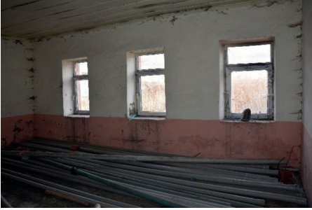
Fotoğraf 22: Taşdeğirmen Köyü İlkokul Binası 2 Nolu Sınıf (B. Karacabey 2023).
