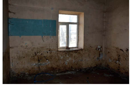
Fotoğraf 8: Bork Köyü İlkokul Binası Lojmanının Mutfağı (B. Karacabey 2023).
