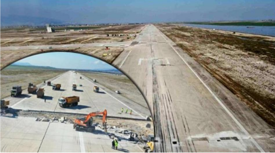
Görsel 9: Hatay Havalimanı Onarım Çalışması (DHMİ, 2023)
