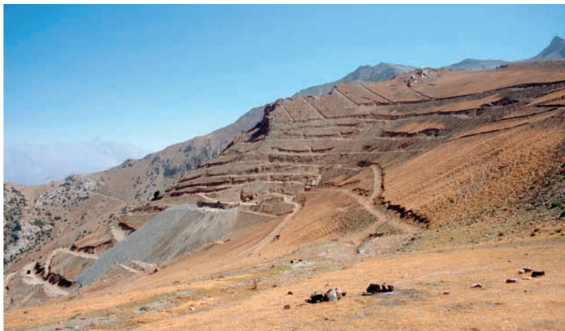
Abb. 18: Mushiston. Blick auf den Berg mit den prähistorischen Bergwerken auf dem Hang. Heute ist diese Hangseite gekennzeichnet von den zahlreichen Prospektionsschürfen sowjetischer Geologen, welche viele alte Baue verschütteten oder zerstörten. Einige konnten vom Tage aus untersucht werden. Auf die graue Halde wurde der Abraum des rezenten sowjetischen Bergbauversuches gekippt. Durch dessen Stollen waren manche alten Baue für uns auch aus dem Berginneren her zugänglich. Sie reichten vom Stollenmundloch ca. 80 m schräg in den Berg.
