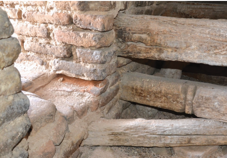
Şekil 4: Hoca Ahmet Yesevi türbesi. Kazanlık kubbesinin arasına giren deliğin yanındaki işlenmiş ahşap bir kütük.
