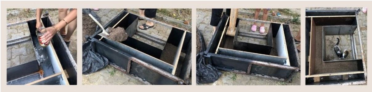
Görsel 9. Toprak karışımın kalıba dökülmesi ve sıkıştırılması aşaması.
