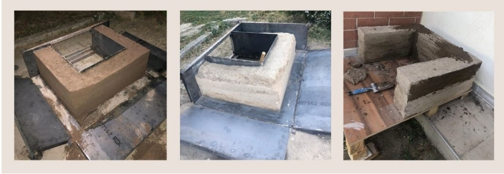
Görsel 10. Kerpiç bloğun kalıptan çıkarılması aşaması.
