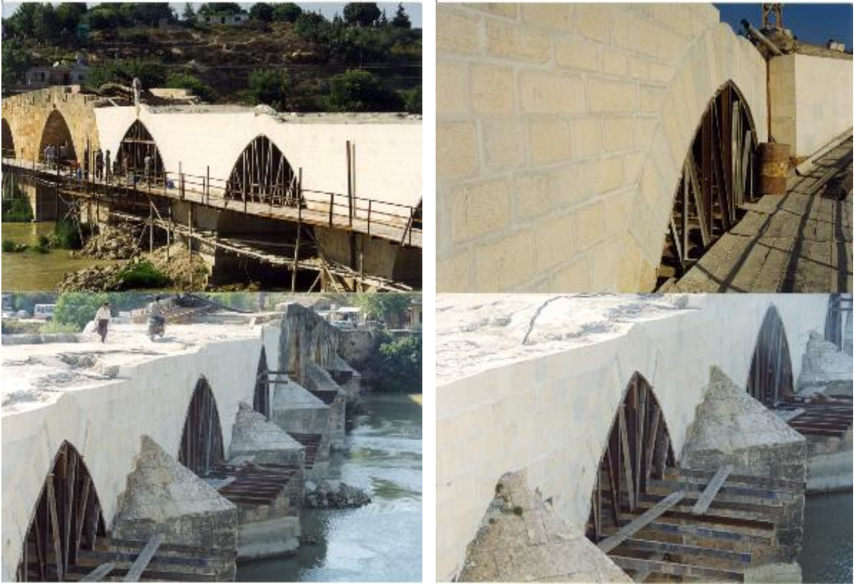
Şekil 10. Köprü Kemerlerinin Restorasyonu (Yeğin, 1998)
