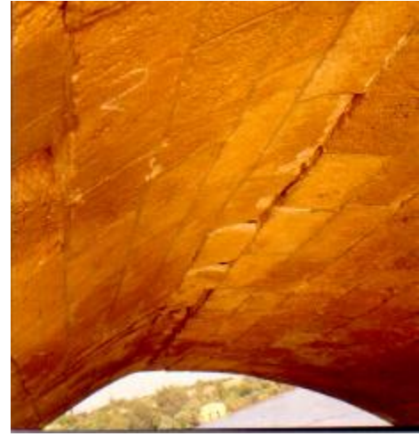
Şekil 7. 1., 2. Kemerlerde Çatlamalar (Yeğın, 1998)
