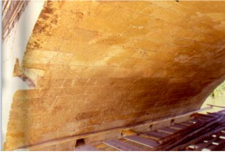
Şekil 7. 1., 2. Kemerlerde Çatlamalar (Yeğın, 1998)
