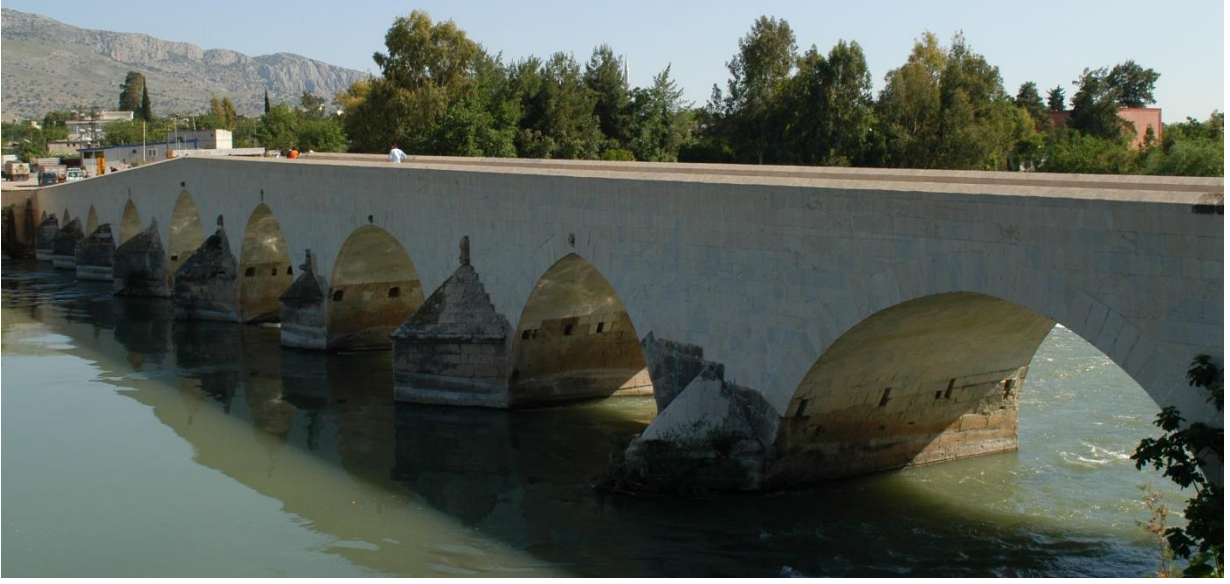
Şekil 12. Misis Köprüsü Görünüş Memba (Yeğın 2005)
