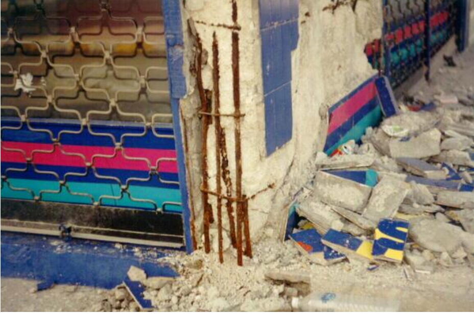
Şekil 1. Deniz Kumu Kullanılarak Yapılan Beton
