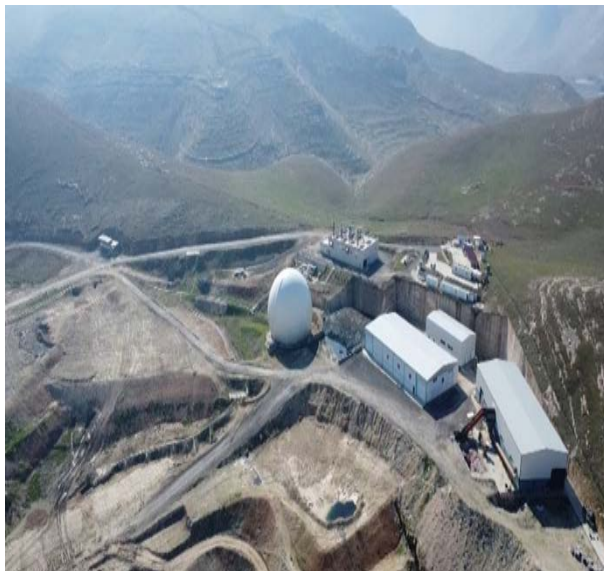
Şekil 8 Tesiste bulunan ünitelerin genel görünümü
