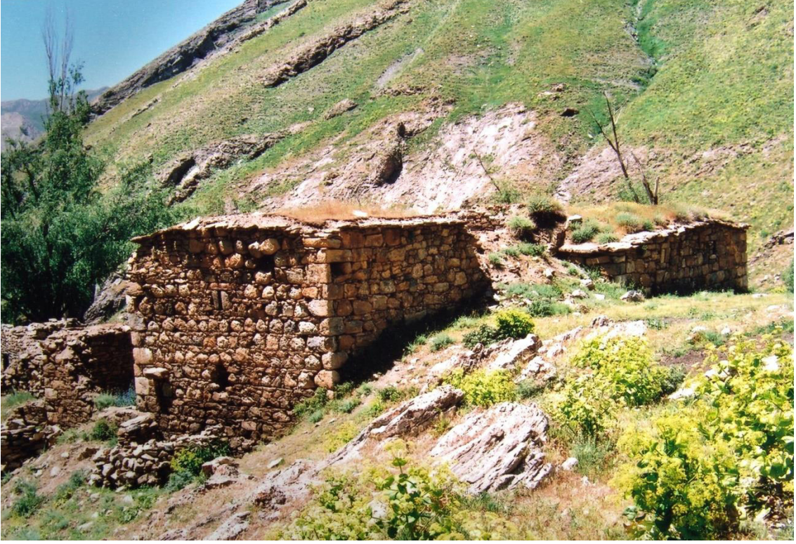
Fotoğraf 14: Saint Georges Kilisesi Kuzey Cephenin Kuzeydoğudan Görünüşü
