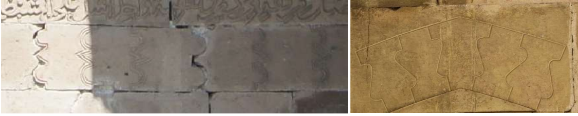
Fotoğraf 2. Divriği Darüşşifası Türbe Giriş Kapısı ve Kayseri-Sahibiye Medresesi, Yalancı Geçme Örneği
