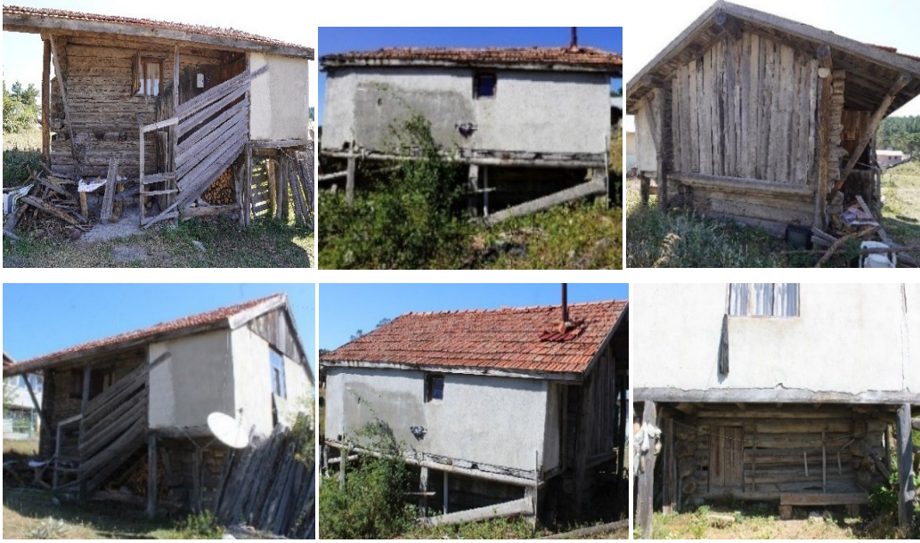
Şekil 7. Akkaya Köyü - Çetmi Mahallesi - Süleyman Bedir Evi (O. Gündoğdu 2024)
