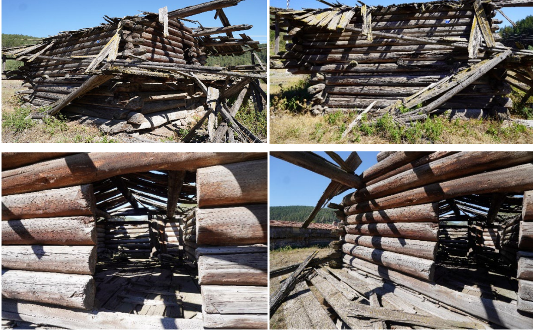
Şekil 16. Uzunyurt Köyü - Yayla Mahallesi Çantı Ev (O. Gündoğdu 2024)
