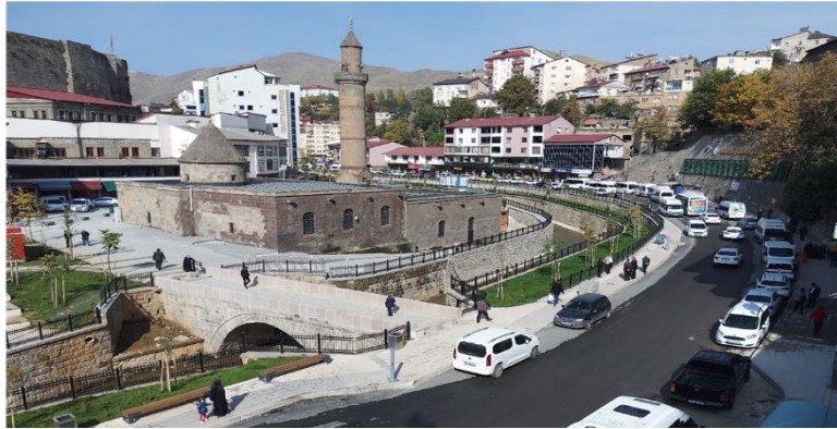
Fotoğraf 1. Ulu Cami ve Nur Caddesi Asfalt Kaplama ve Diğer Yapım İşlerinden Bir Görünüm (Kaynak: Yazarlar)
