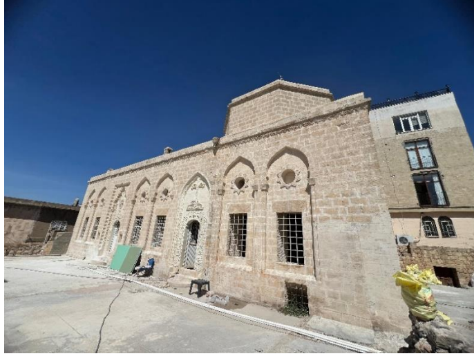
Fig. 13: Birinci kat, teras ve güney dış cephesi (2025)
