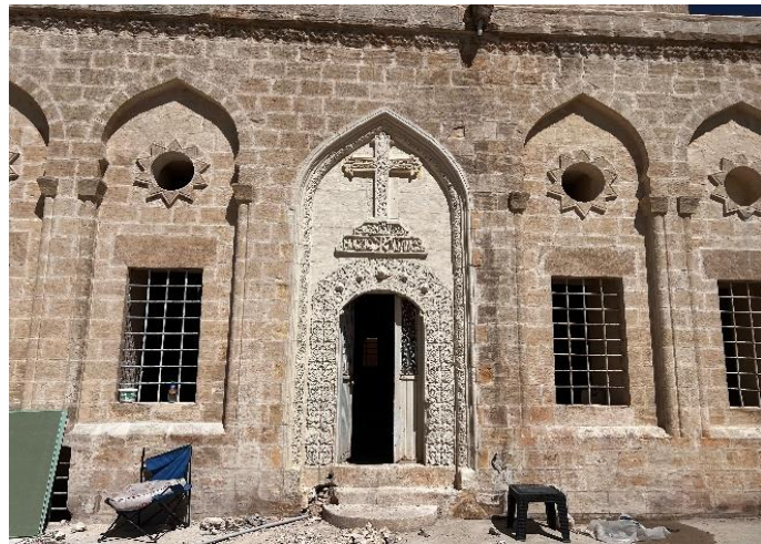
Fig. 15: Birinci kat, güney cephesi sağ yöndeki kapı (2025)
