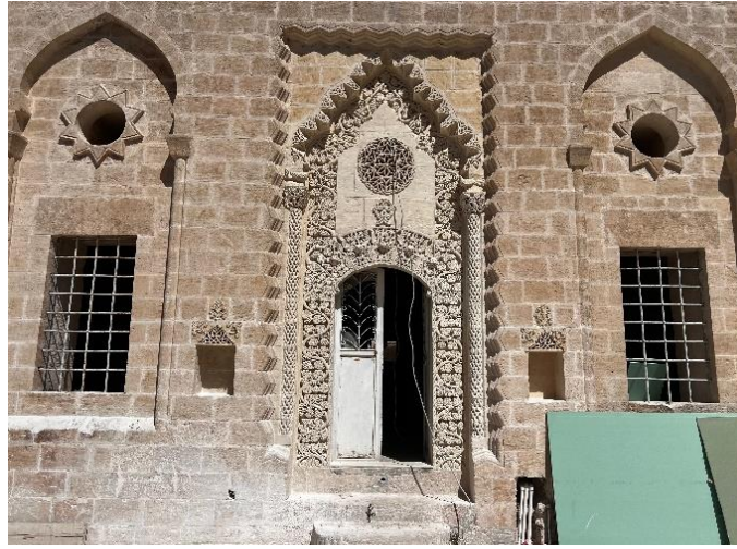
Fig. 14: Birinci kat, güney cephesi sol yöndeki kapı (2025)
