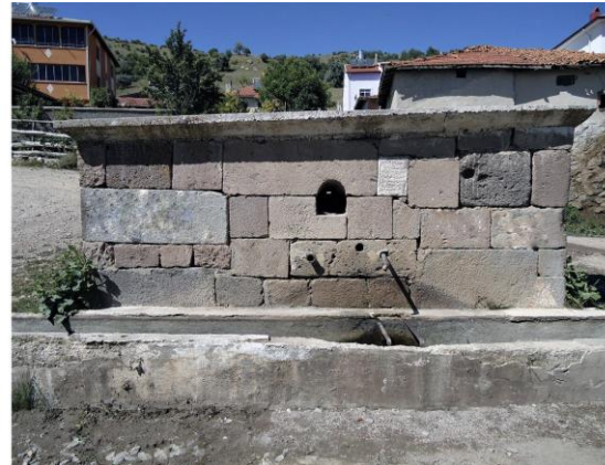
Fig. 9: Çankırı Kayıören Köyü Çeşmesi II (Demirtaş 2022, 282)
