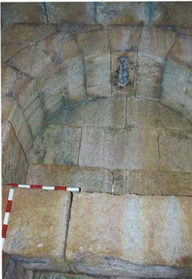
Res. 8: D1 mezar anıtının çatı konstrüksiyonunu oluşturan kemer ve kapama blokları.
