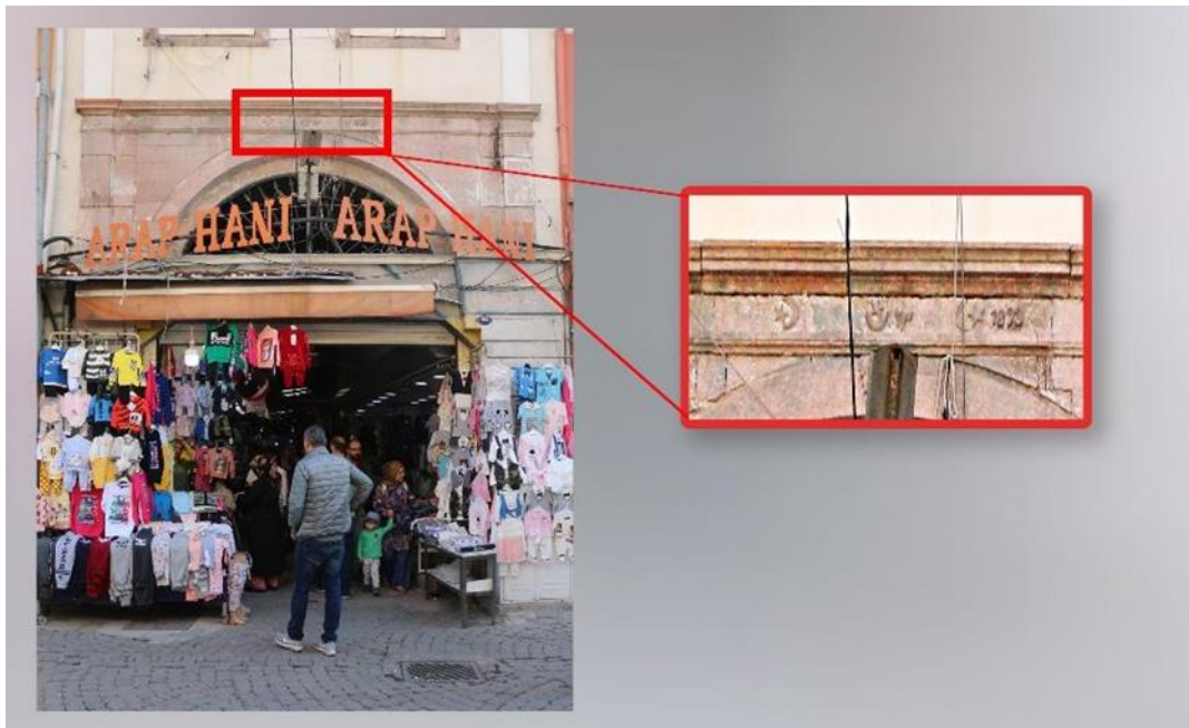
Şekil 3. Arap Hanı'nın kuzey cephesinden görünümü (2019)
