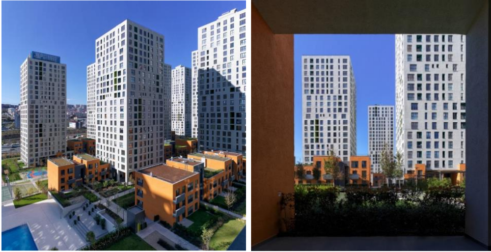
Şekil 7. Hep İstanbul projesinin görünüş fotoğrafları (CM Mimarlık, 2024)
