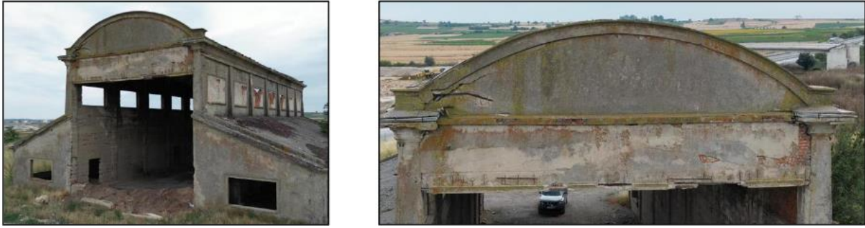
Şekil 15.a Kuzeydoğu Cephesi 15.b Kuzeydoğu Cephesi alınlığı (Bayram, 2024: Şekil D.28, D.29).
