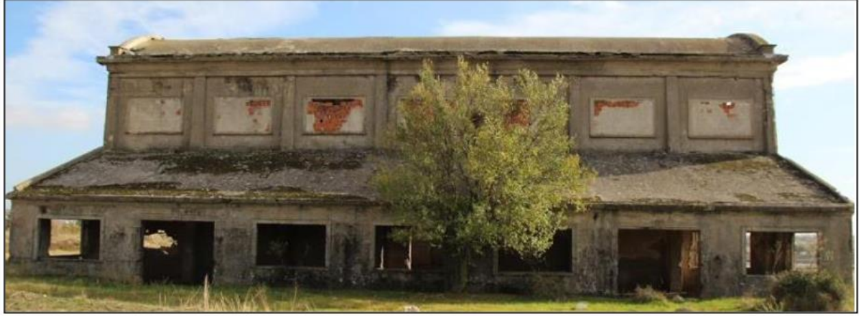
Şekil 21. Kuzeybatı Cephesi (Bayram, 2024: Şekil D.31).
