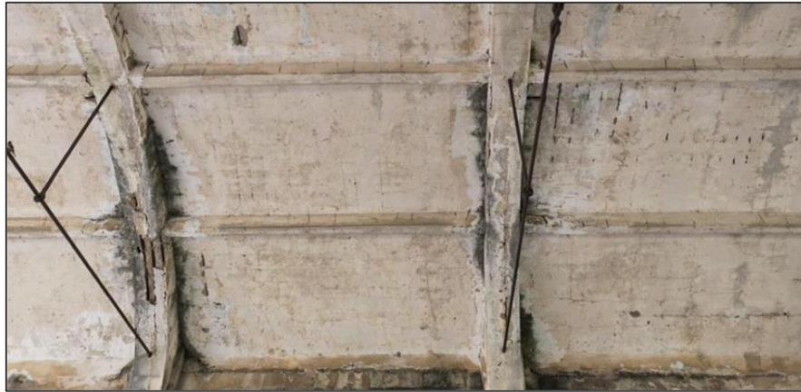
Şekil 22. Ana Sahında Bulunan Betonarme Kemer ve Kirişler (Bayram, 2024: Şekil D.44).
