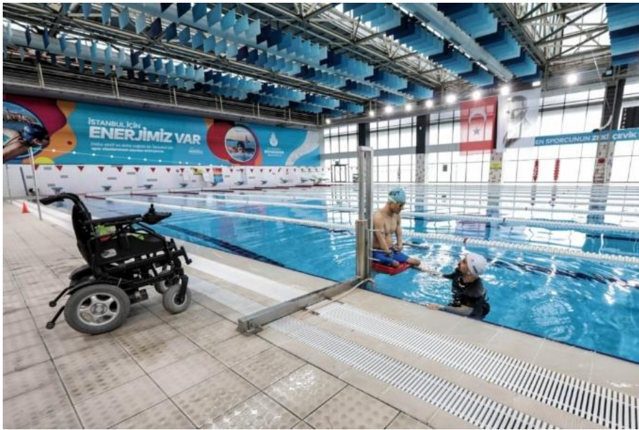
Şekil 7. Havuz hidrolik platform kullanımı (İBB, 2023).
