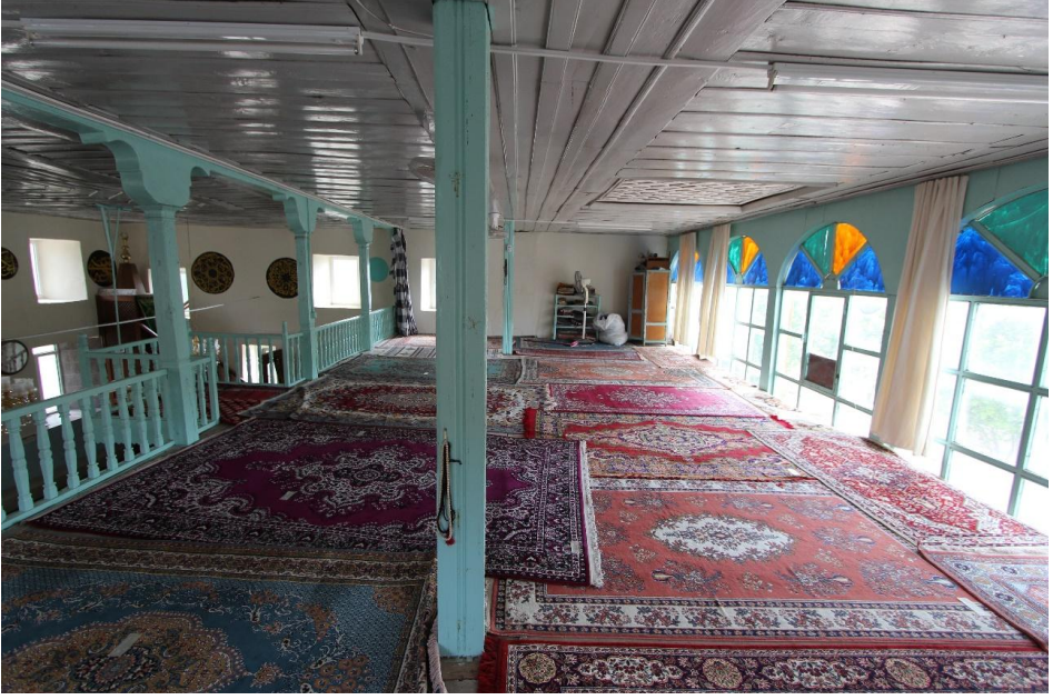
Fotoğraf 21: Hisarköy Camisi Mahfil Katındaki Ahşap Taşıyıcı Ayaklar
