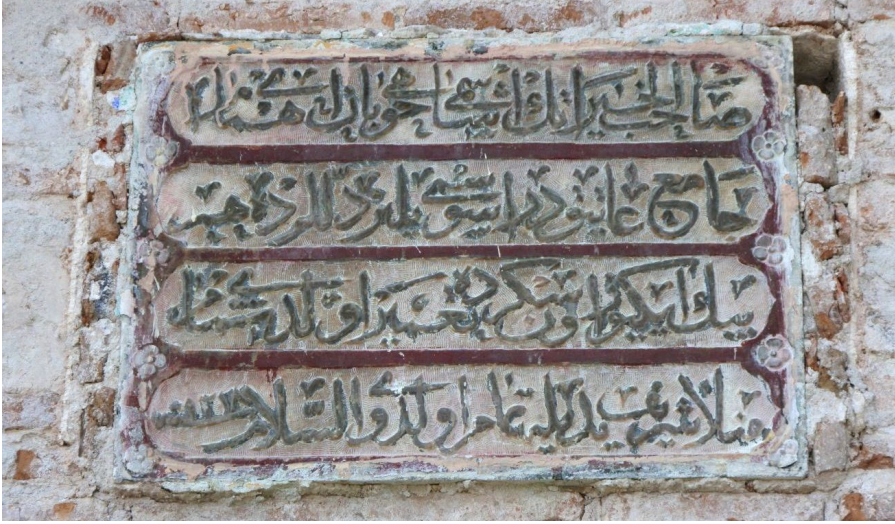
Fot.4- Harim girişı üzerindeki onarım kitabesi.
