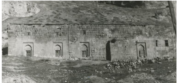
Fot. 10b: Cephede görülen yapı genişleme hattı; Yapının 20. yy.'daki görünümü ve doğu uçtaki ek yapı (VGMA)
