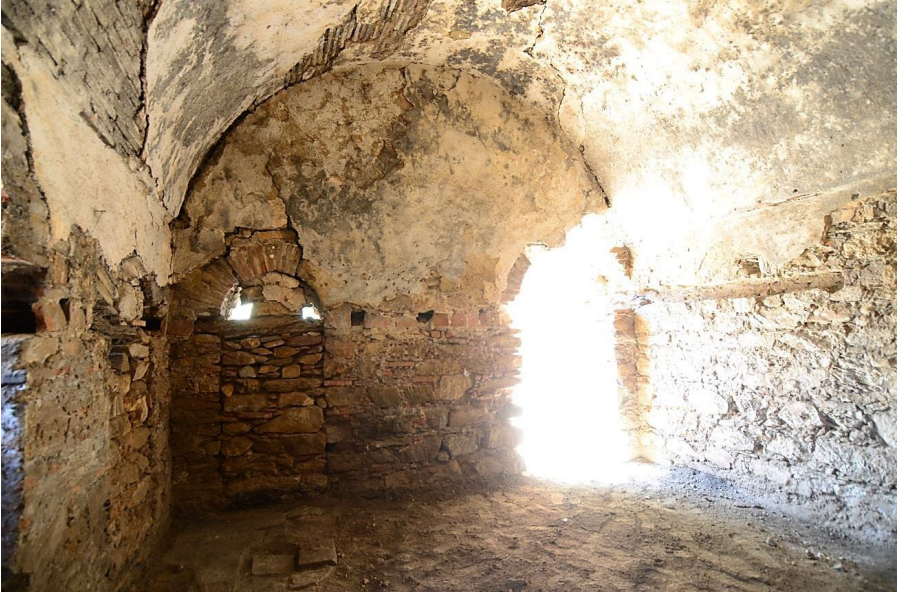
Fot.15- Mekanın güney duvarı, giriş ve pencere.
