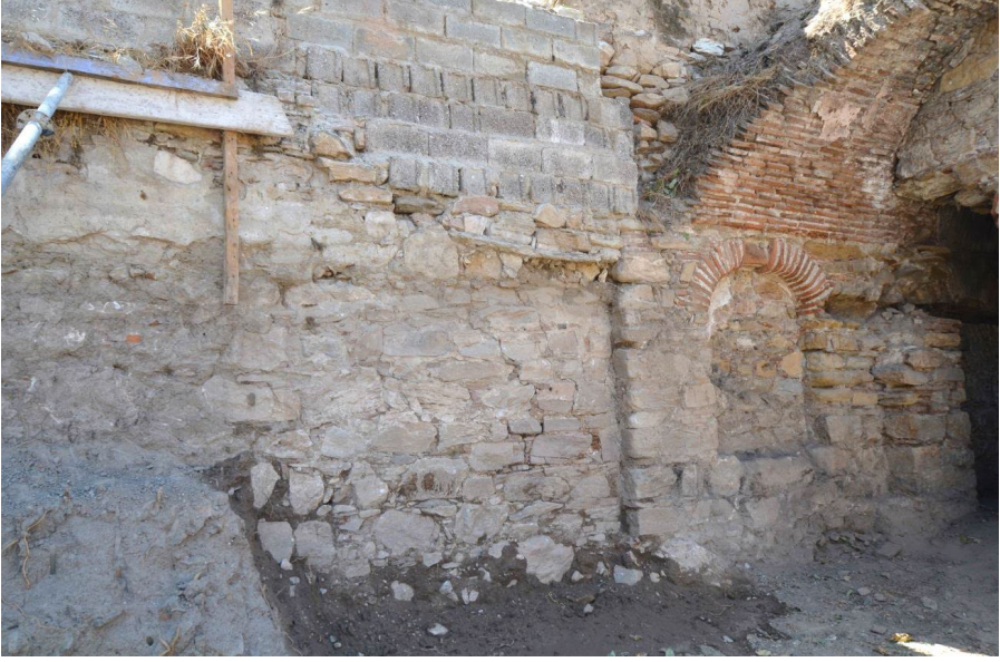
Fot.10- Avluyu batıdan sınırlayan duvarın kuzey ucu, temizlik çalışması sonrası görünüş.
