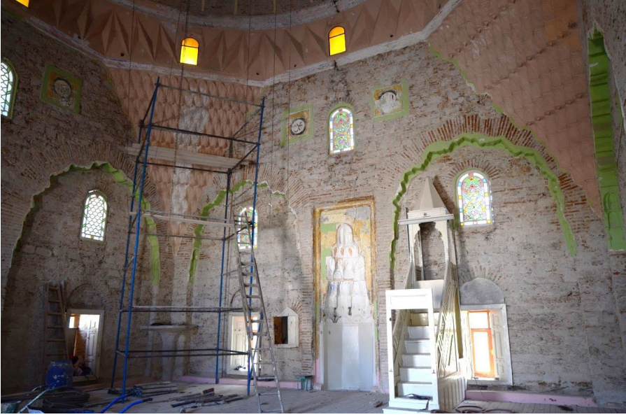
Fot.3- Harim (kısmi sıva raspası sonrası).
