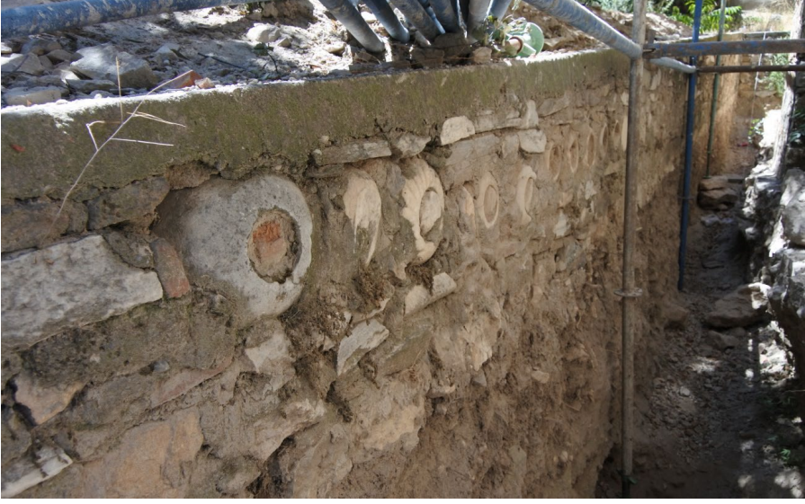
Fot.21- Dolgu malzemesi olarak kullanılan mezartaşları örnekleri.
