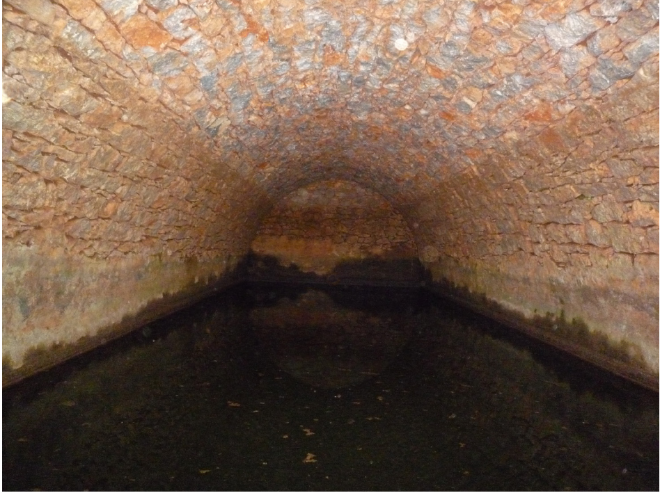
Fot. 2: Düzen Sarnıcı'nın tonoz örtüsü
