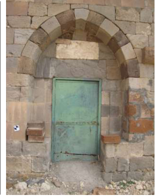
Fot. 8: Batı cephesinde yer alan sivri kemerli giriş kapısı ve muhdes demir kapı.
