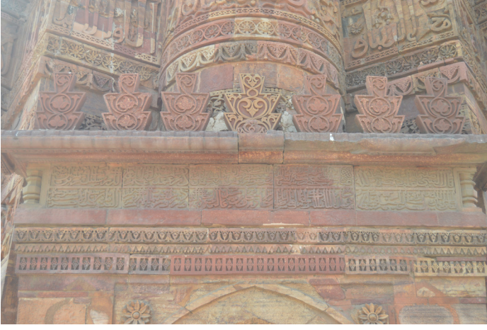
Görsel: 33 Birinci Kat, Giriş Kapısı (Özler Kaya, 2016)
