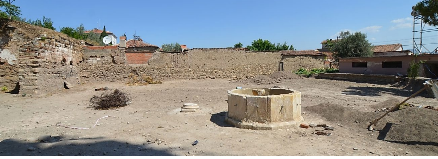
Fot.18- Temizlik çalışmaları sonrası avlu.
