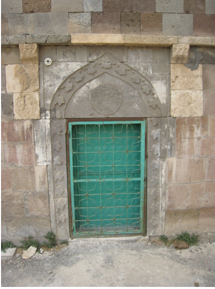
Fot. 2: Doğu cephesi kapısının görünümü
