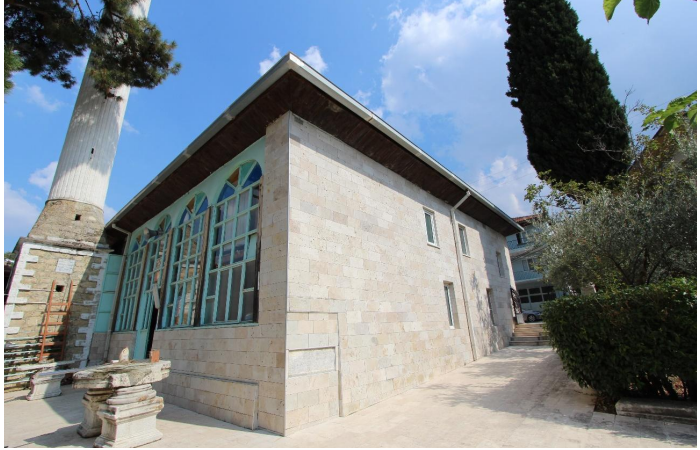
Fotoğraf 14: Hisarköy Camisi Batı Cephesi
