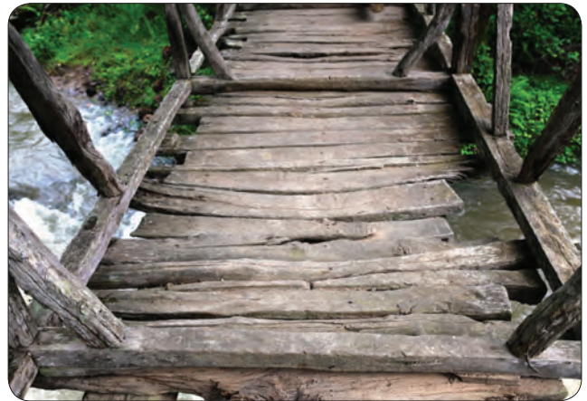
Fotoğraf 14 - Giresun Lapa Köyü Ahmet Ağa Köprüsü tabliyeden detay / Ahmet Ağa Bridge details from the deck at Lapa Village in Giresun
