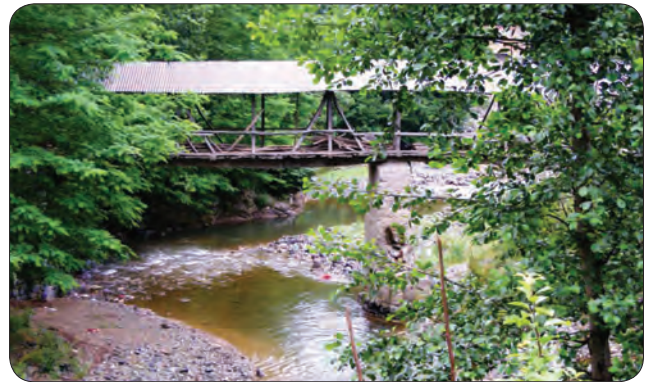
Fotoğraf 19 - Giresun Uzkara-Sayca Köyleri sınırında Ezirkan (Dillioğlu) Köprüsü kuzey (menba) cephe / Ezirkan (Dillioğlu) Bridge north (upstream) facade at the border of Uzkara-Sayca Villages (Giresun)
