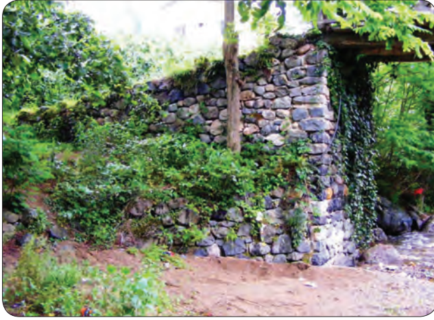
Fotoğraf 22 - Giresun Uzkar-Sayca Köyleri sınırında Ezirkan (Dillioğlu) Köprüsü ayağı doğu taraf, kuzeyden / Ezirkan (Dillioğlu) Bridge abutment east side (northerly) at the borders of Uzkar-Sayca Villages (Giresun)
