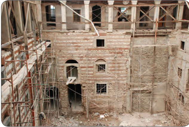
Fotoğraf 2 - Muhsinzade Hanı, avludan görünüş (2009) / Muhsinzade Khan courtyard view (IV Numaralı Kültür Varlıklarını Koruma Bölge Kurulu Arşivi)
