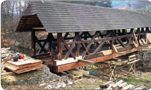
Fotoğraf 38 - Çek Cumhuriyeti'nde geleneksel ahşap bir köprü / Traditional wooden bridge in Czech Republic. (Svratka river (Černvív)) https://commons.wikimedia.org/wiki/Category:Wooden_bridge_over_the_Svratka_river_(%C4%8Cernv%C3%ADr)
