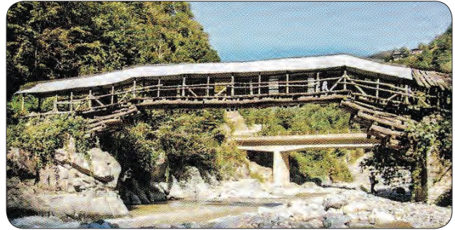
Fotoğraf 30 - Rize - Çayeli Buzlupınar Köyü Köprüsü (Çabuk vd. 2015) / Buzlupınar Bridge at Buzlupınar Village in Çayeli-Rize (Çabuk at. al. 2015)
