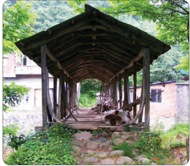
Fotoğraf 18 - Giresun Uzkara-Sayca Köyleri sınırında Ezirkan (Dillioğlu) Köprüsü batı cephe / Ezirkan (Dillioğlu) Bridge west facade at the borders of Uzkara-Sayca Villages (Giresun)
