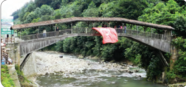
Fotoğraf 27 - Trabzon - Of Bölümlü Köyü Hapsiyaş (Kiremitli) Köprüsü / Hapsiyaş (Kiremitli) Bridge at Bölümlü Village in Of-Trabzon
