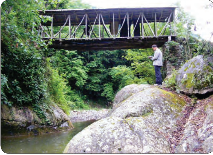
Fotoğraf 2 - Giresun Hisareriş-Sayca Köyleri sınırında Han Köprüsü doğudan / Han Bridge east at the borders of Hisareriş – Sayca Villages (Giresun)
