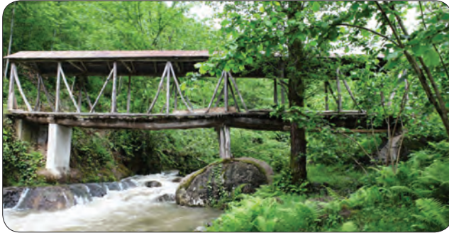
Fotoğraf 11 - Giresun Lapa Köyü Ahmet Ağa Köprüsü mansab (batı) cephe / Ahmet Ağa Bridge west face (downstream) at Lapa Village in Giresun
