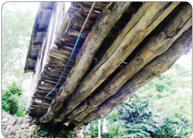
Fotoğraf 4 - Giresun Hisarçeriş-Sayca Köyleri sınırında Han Köprüsü ana kirişler / Han Bridge main beams at the borders of Hisarçeriş – Sayca Villages (Giresun)
