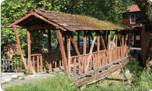
Fotoğraf 34 - Kastamonu - Bozkurt Yakaören (İlişi) Köyü Cumayanı Köprüsü / Cumayanı Bridge at Yakaören (İlişi) Village in Bozkut – Kastamonu
