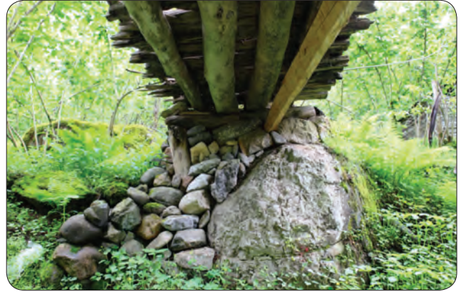
Fotoğraf 12 - Giresun Lapa Köyü Ahmet Ağa Köprüsü tabliye (güney kesim - alttan) / Ahmet Ağa Bridge deck (the southern part - below) at Lapa Village in Giresun
