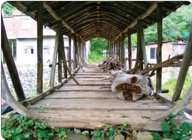
Fotoğraf 25 - Giresun Uzkara-Sayca Köyleri sınırında Ezirkan (Dillioğlu) Köprüsü iç yapı (batıdan) / Ezirkan (Dillioğlu) Bridge internal structure of the west at the borders of Uzkara-Sayca Villages (Giresun)
