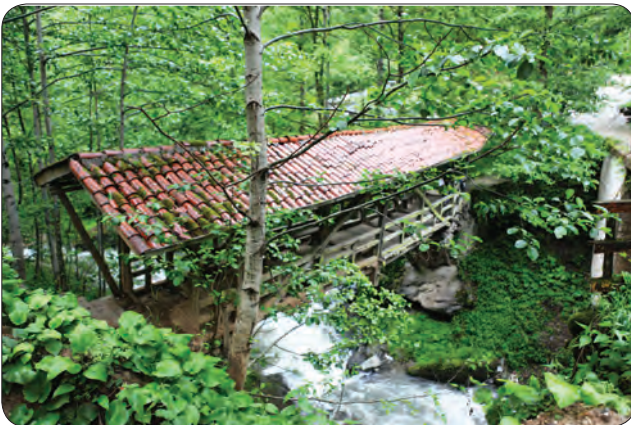
Fotoğraf 28 - Trabzon - Çaykara Eğridere Köyü Kiremitli Köprü / Kiremitli Bridge at Eğridere Village in Çaykara-Trabzon
