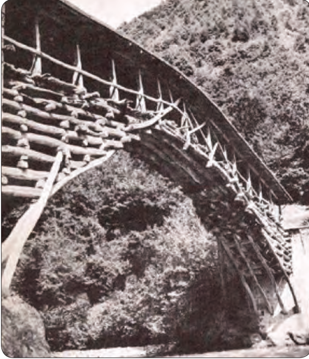
Fotoğraf 26 - Trabzon - Of Bölümlü Köyü Hapsiyaş (Kiremitli) Köprüsü (Özgüner 1970) / Hapsiyaş (Kiremitli) Bridge at Bölümlü Village in Of-Trabzon (Özgüner 1970)
