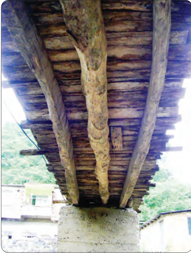
Fotoğraf 24 - Giresun Uzkara-Sayca Köyleri sınırında Ezirkan (Dillioğlu) Köprüsü ana kirişler / Ezirkan (Dillioğlu) Bridge main beams at the borders of Uzkara-Sayca Villages (Giresun)
