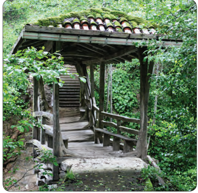
Fotoğraf 29 - Trabzon - Çaykara Eğridere Köyü Kiremitli Köprü / Kiremitli Bridge at Eğridere Village in Çaykara-Trabzon
