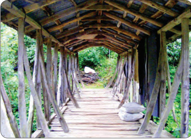
Fotoğraf 6 - Giresun Hisargeriş – Sayca Köyleri sınırında Han Köprüsü iç yapı (kuzeyden) / Han Bridge, bridge internal structure (from the north) at the borders of Hisargeriş – Sayca Villages (Giresun)
