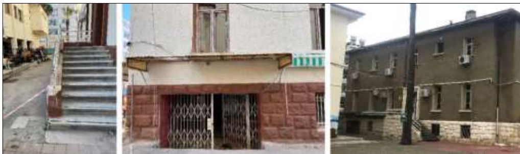
Şekil 29. Zemin kotu altında kalan basamaklar (solda) ve cephede ilaveler (orta, sağda) (Yazarlar)
