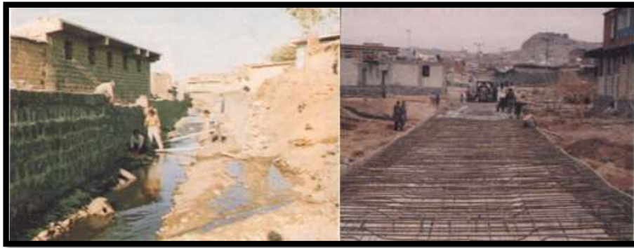
Şekil 3. 1993 yılında Esmer Çayının üstünün kapatılmadan önceki hali ve kapatılma anı (Siverek Belediyesi, 2023).
