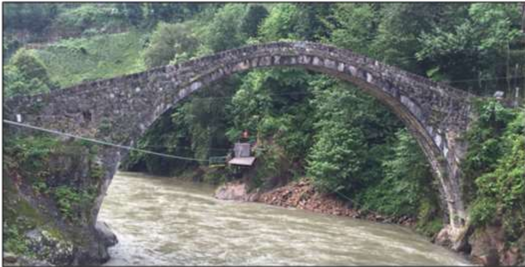
Şekil 6: Tek açıklıktan oluşan taş köprülerde örüntü dili; Timisvat Köprüsü (Köprüköy Köprüsü) Rize-Ardeşen-Köprüköy Köyü (Yazarın Arşivi)
