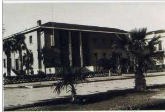
Şekil 19. 1945'li yıllarda İskenderun Halkevi Binası (Mursaloğlu, 2000)
