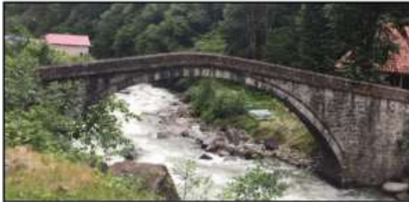
Şekil 4a (solda): Tek açıklıktan oluşan taş köprülerin “yer”e müdahale biçimi; Kavak Köprüsü Rize-Çamlıhemşin-Aşağı Şimşirli Köyü (Yazarın Arşivi)
