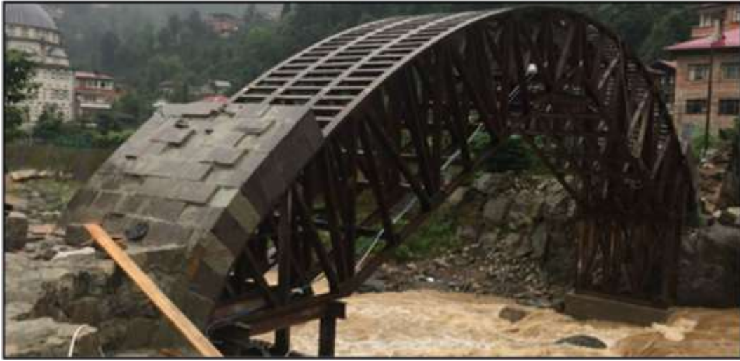
Şekil 14: Özgün olmayan yapım yöntemiyle “yeniden” inşa edilen taş köprü; Ambarlık Köyü Köprüsü, Rize-Merkez-Ambarlık Köyü (Yazarın Arşivi)
