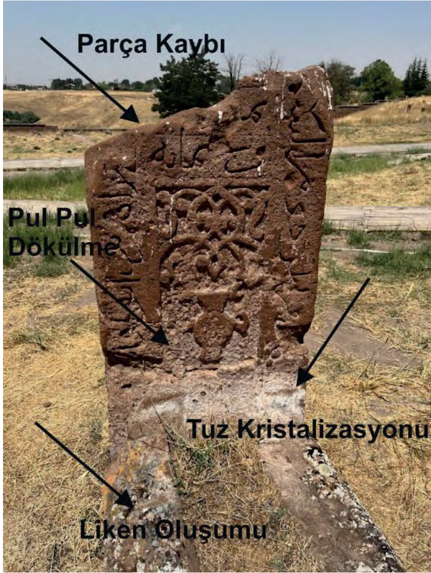
Şekil 6. Selçuklu Mezarlığı'nda yer alan anıtsal Ahlat taşı mezar taşlarında gözlenen başlıca bozunma türleri.
