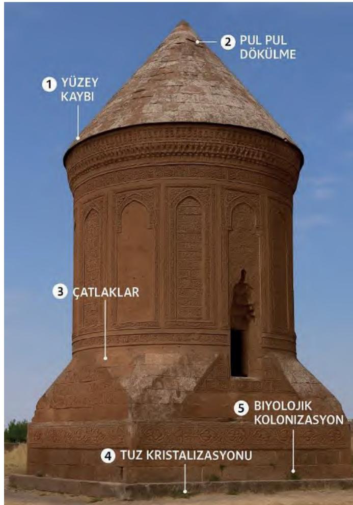
Şekil 7. Ulu Kümbet'te gözlenen başlıca bozunma türleri.
