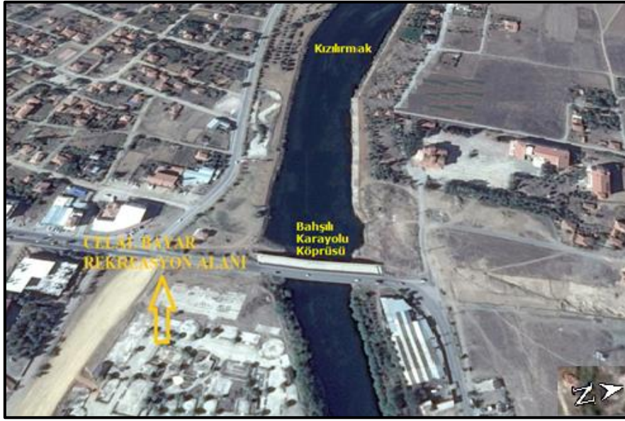
Şekil 3. Bahşılı karayolu köprüsü ve Celal Bayar rekreasyon alanı
