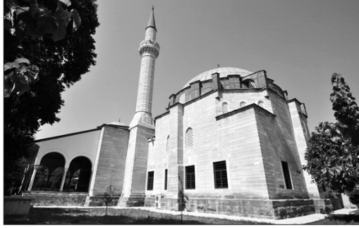
Foto-7: Camiinin batı ve güney cephesinden görünüm.
