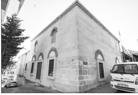
Foto-21: Hamamın kuzey ve güney cephesinden görünüm.
