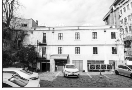
Foto-22: Hamamın güney cephesindeki ek yapı
