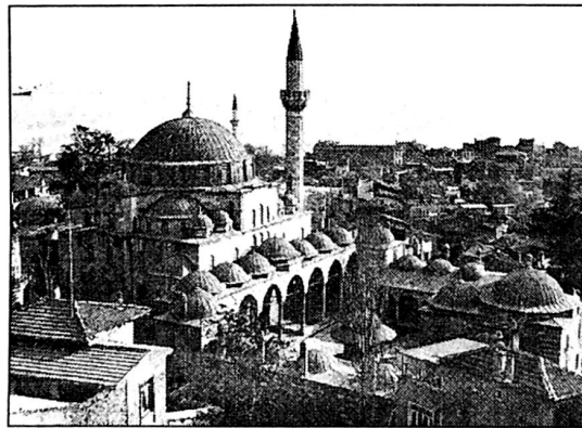
Şekil 17. Kadırga Sokullu Mehmet Paşa Külliyesi (8)
