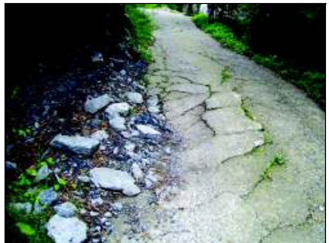
Şekil 5b: Tasmanın Altyapı Tesislerindeki Etkileri (AKÇIN 2007)
