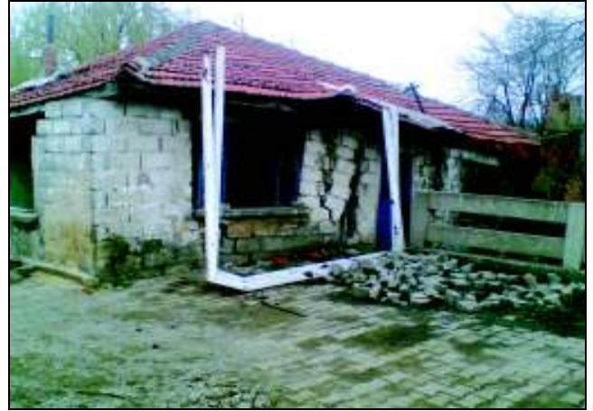
Şekil 5a: Taşkömür Havzasında Tasmandan Etkilenen Binalar (AKÇIN 2007)
