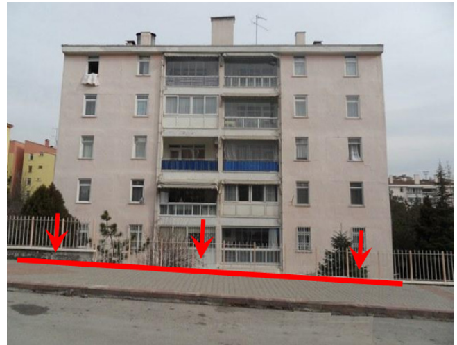
Şekil 9: Bina temeli ile yol arasındaki kot farkının görünümü
