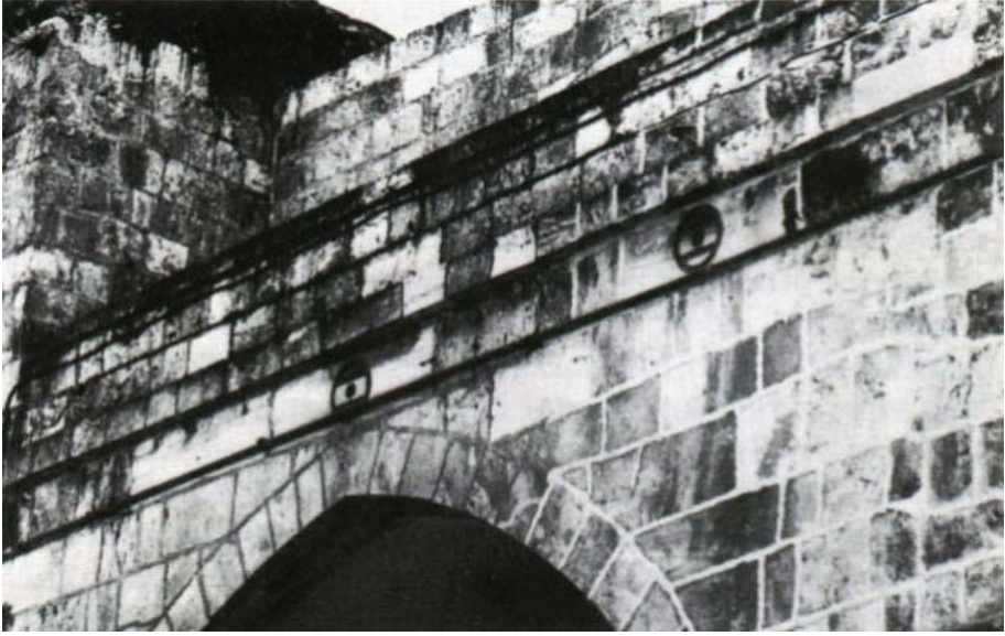
Fotoğraf 6. Cavliyye Medresesi Eyvanında Hançe Armaları ( https://archnet.org/media_contents/61703 ).
