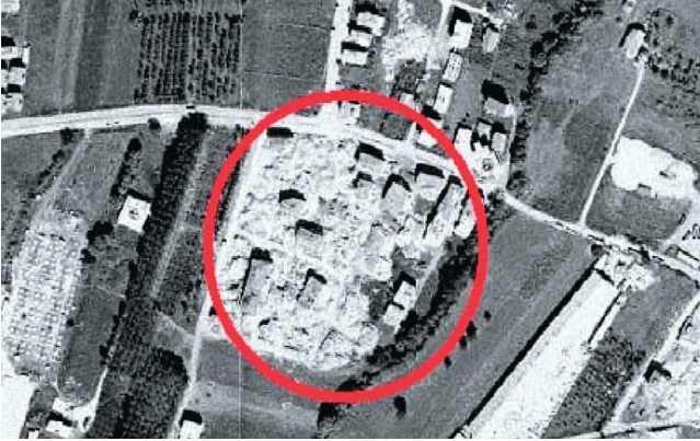
Şekil 5: Ortofoto Üzerinde Hasar Tespiti
