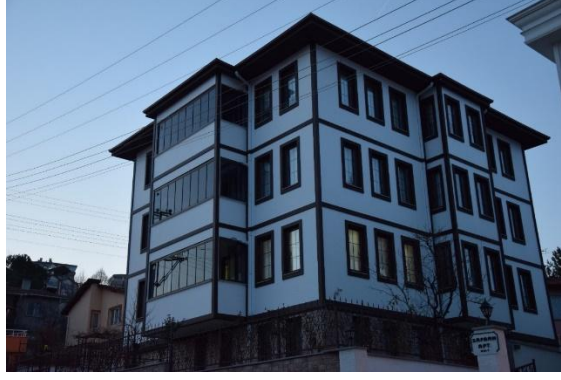
Foto 14. Safran Apartmanı , yan ve arka cephesi
