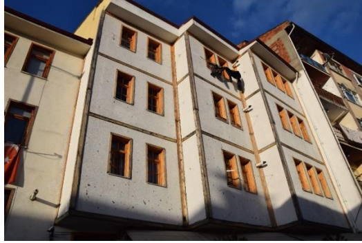
Foto 9. Zincirlioğlu Apartmanı, detayı
