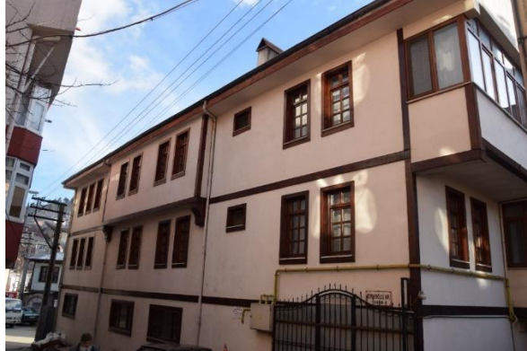
Foto 7. Kırıkoğlu Apartmanı, arka cephesi
