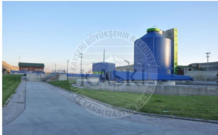
Resim 7: Kayseri atık su arıtma tesisi
