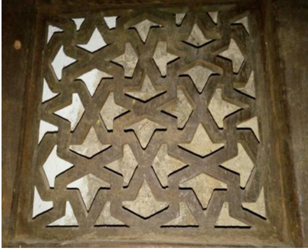
Fotoğraf 23. Diyarbakır Ali Paşa Camii Minber Korkuluğu
