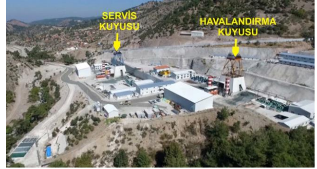
Şekil 2. Havalandırma ve Servis Kuyusu Kazı Bölgesi
