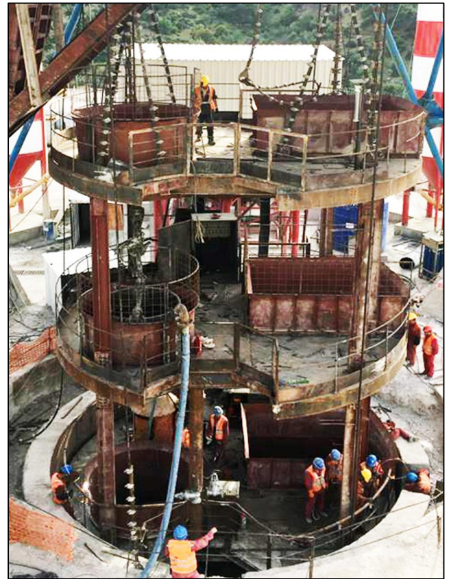
Şekil 6. Kazı Platformunun Kurulumu
