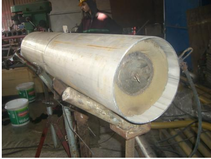
Foto 10. Klasik yöntemle Montajı ve koruma gazı barajları tamamlanmış boru.
