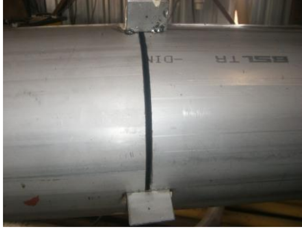
Foto 9. Boruların montajı ve hizalanması
