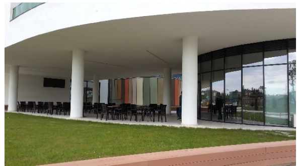
Resim 9. Konya Gıda ve Tarım Üniversitesi Yerden Yükseltilerek İnşa Edilen Kısım
