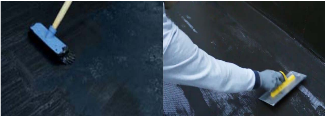
Şekil 4. B-SYM’nin ilk kat uygulaması (solda) [20], B-SYM’nin ikinci kat uygulaması (sağda) [21] (First layer application of “bitumen based liquid waterproofing -BBLW” (left) [20], Second layer application of BBLW (right) [21])
