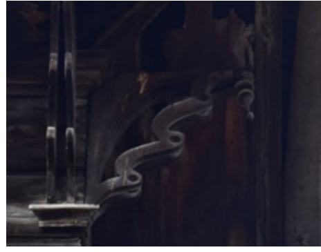
Fotoğraf 28: Yusuf Kereste Evi. Çatı saçağı payandası
