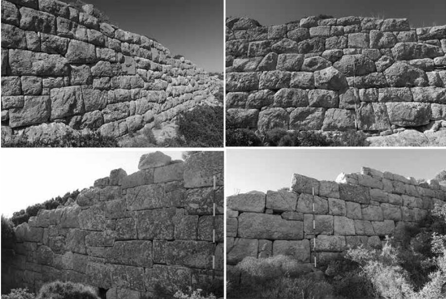
Fig. 12 Kap Krio Batı Surundaki Farklı Örgü Tekniklerindeki Duvarlar
