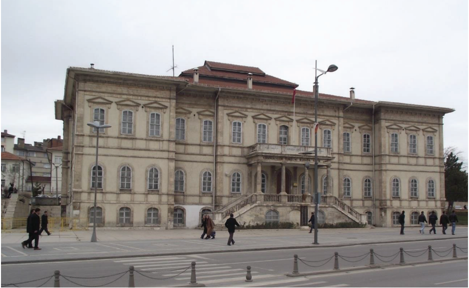
Fot. 2: Sivas İdadî Binası Neo-Klasik Düzendeki Tasarlanan Ana Cephesi (E. Kolay, 2010)
