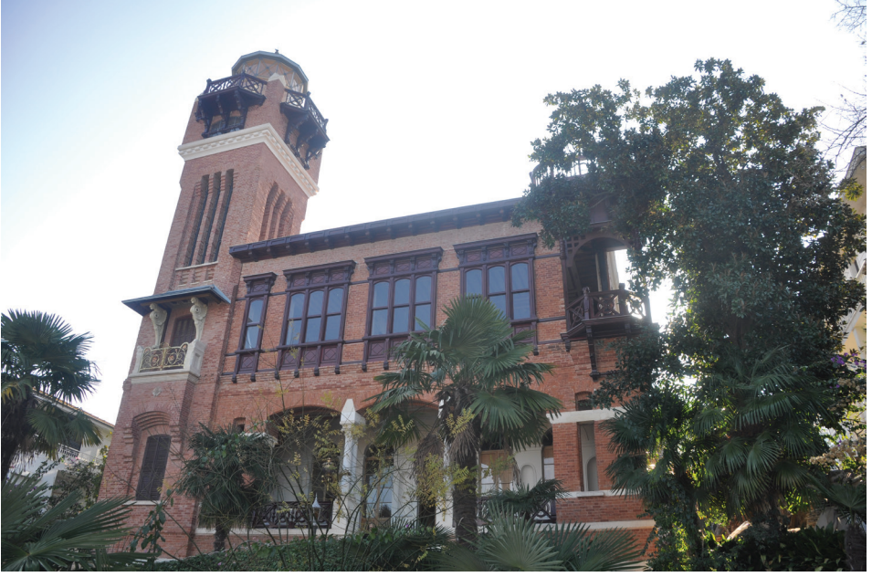
Fot. 2: Mizzi Köşkü'nün kuzey yönündeki ön cephesi (H. Adıgüzel, 2019)
