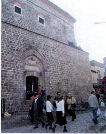
Resim 8. Bedesten'in restorasyon sonrası kuzey girişi
