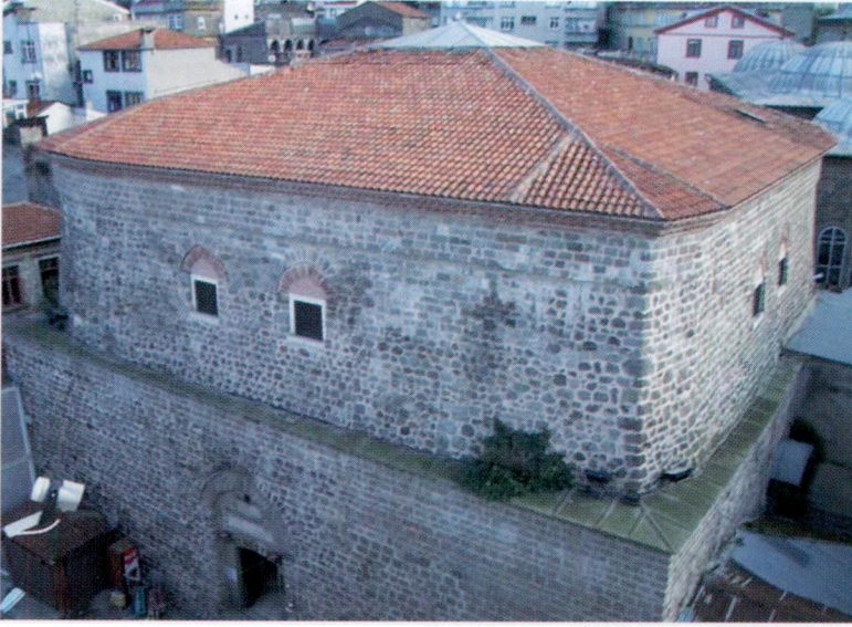
Resim 7. Bedesten'in restorasyon sonrası kuzey cephesi
