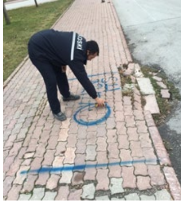
Şekil 7. Çalışma alanında yer mikrofonu ile yer tespit çalışmaları
