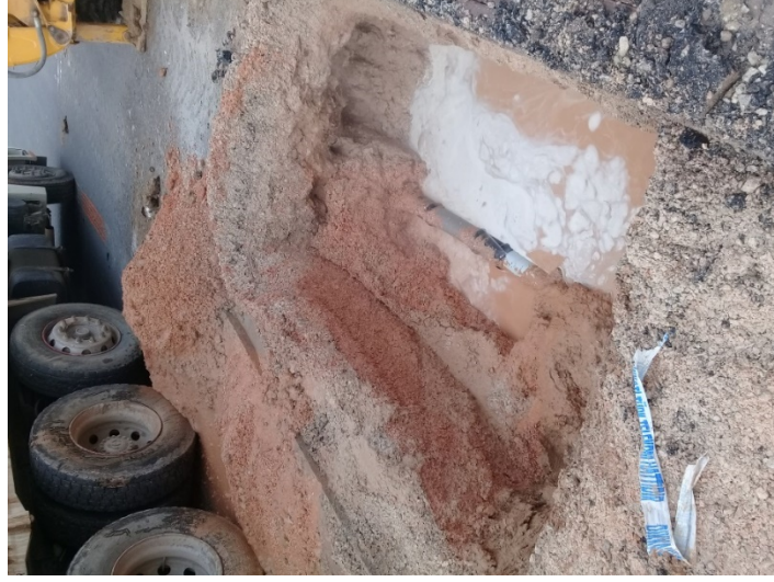
Şekil 10. Step Test Çalışması Arıza Tespiti
