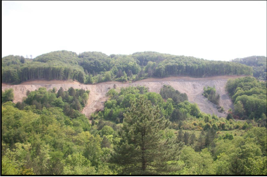
Şekil 8. Gelişigüzel depolanan hafriyat nedeniyle yamaç doğrultusunda hareket eden topraklar bitki örtüsüne önemli zararlar vermektedir (Figure 8. Because of the excavation randomly stored, the soil moving down the slopes damaged the flora)
