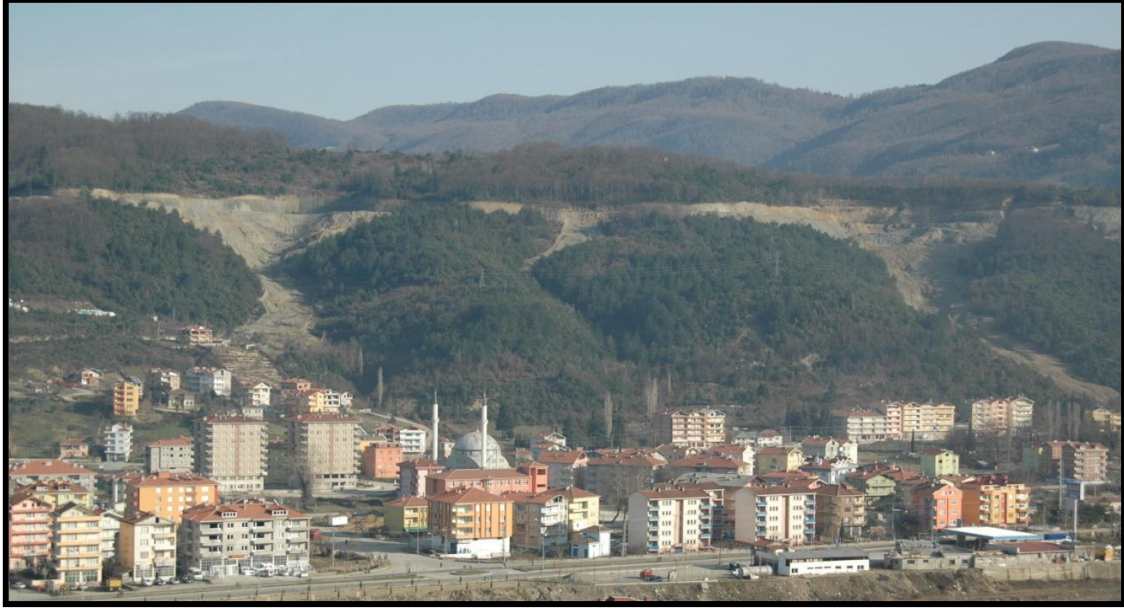
Şekil 10. Cevizli Mahallesi batısında su iletim kanalı inşaatları nedeniyle kazı çalışmalarında çıkarılan topraklar vadi içerisinde gelişigüzel biriktirilmiştir. Zamanla eğime uygun olarak akan bu topraklar etekteki meskenleri tehdit etmeye başlamıştır (Figure 10. The soil that was excavated during the construction of water transmission canal in the west of cevizli district was stored randomly in the walley. Later the soil moving down the walley has started to threaten the settlement on the foot of the hill)
