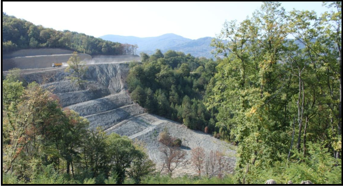
Şekil 9. Yamaca biriktirilen hafriyat yağışların da etkisiyle eğim doğrultusunda hareket etmiştir (Figure 9. Excavation stored on the slope moved down because of the rain)
