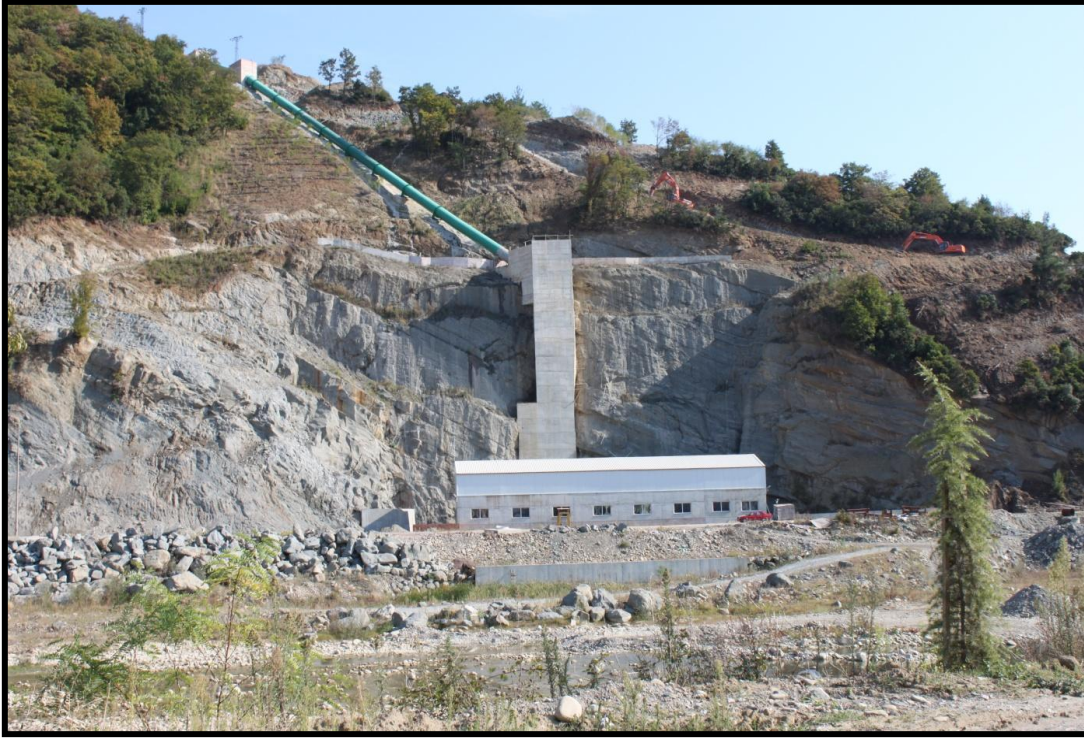
Şekil 4. Ayancık HES santral binası (Figure 4. The power house of Ayancık HEPP)
