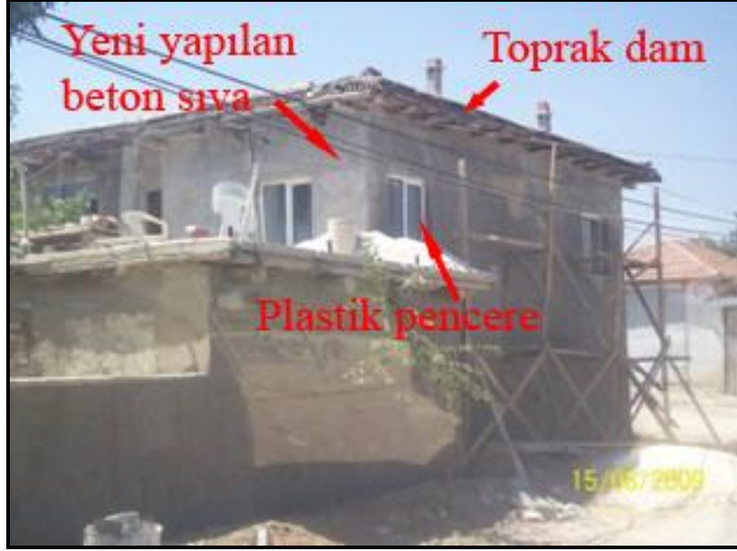
Foto 4. Günümüzde eski tip konutların bazıları modern malzemeler kullanılarak yeniden düzenlenmektedir (Harmanlı köyü). (Photo 4. Today some old-style houses are restored with modern materials) (Harmanlı village)
