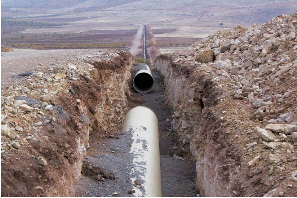
Fotoğraf 11. Kapalı sulama sistemlerinin yapım aşamasından bir görünüm (Photo 11. A view of closed irrigation systems during construction process)
