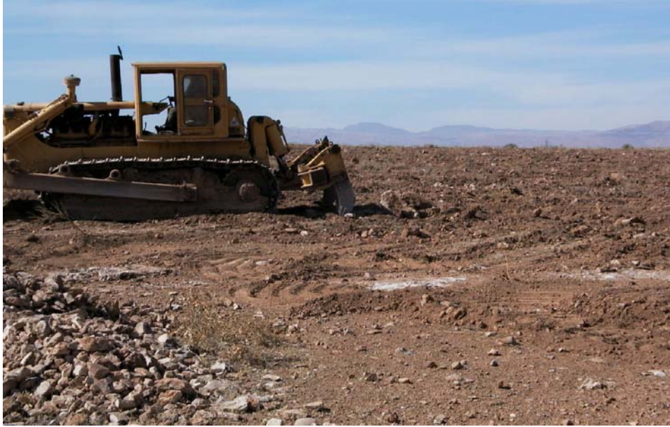
Fotoğraf 7. Riperleme işlemlerine bir örnek çalışmadan görünüm (Photo 7. A view from a ripping process)
