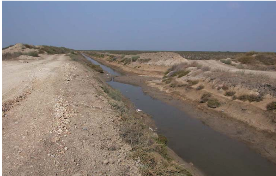
Fotoğraf 10. Açık drenaj kanallarından bir örnek görüntü (Photo 10. An example view of open drainage canals)
