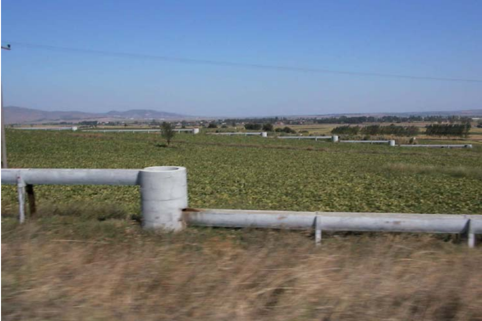
Fotoğraf 6. Arazi toplulaştırması sonucu yapılan tarla içi sulama kanallarına bir örnek görünüm (Photo 6. An example view of in-field irrigation canals built as a result of land consolidation)
