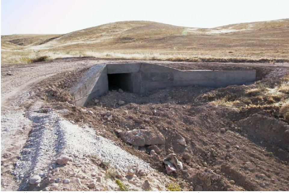
Fotoğraf 9. Arazi toplulaştırma işlemleri sırasında Altyapı çalışmalarına ve ulaşım yollarının yapımına bir örnek (Photo 9. An example of infrastructure works and Access roads construction during the land consolidation process)
