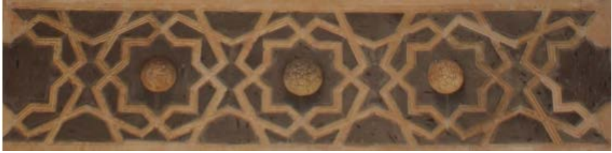
Fotoğraf 3- Latifiye Camii Taç Kapı Bordür Detayı
