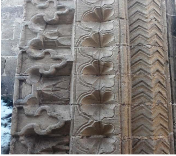
Fotoğraf 11- Şehidiye Camii Taç Kapı Silmeleri
