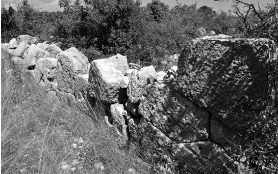
Res. 25 Güvercinlik Çatalkuyu peristyle avlulu konutun polygonal duvarları
