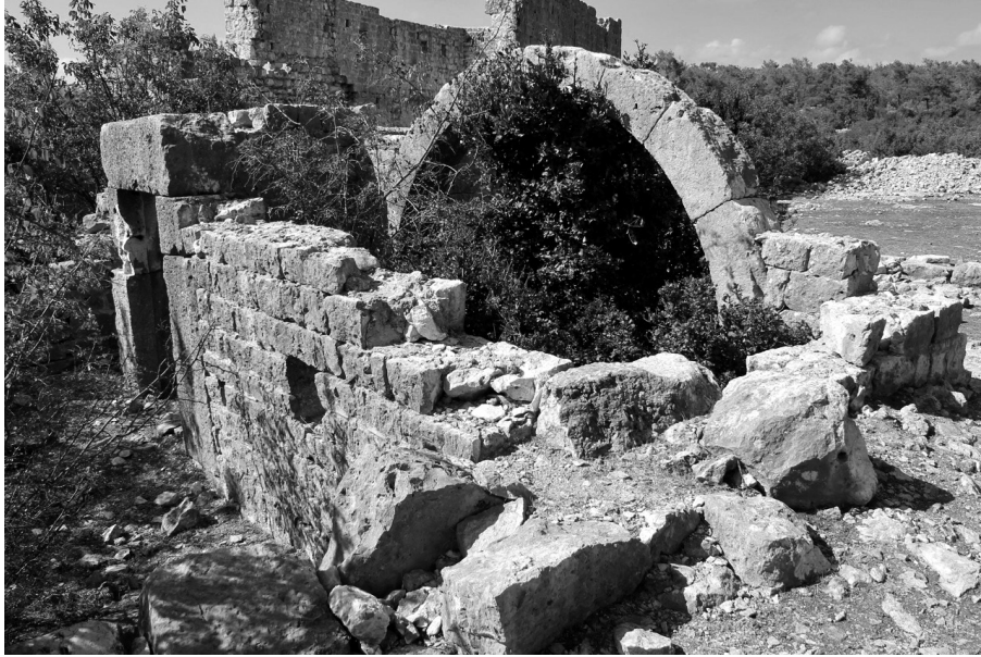
Res. 33 Karakabaklı peristyle avlulu konut 2, duvarlar
