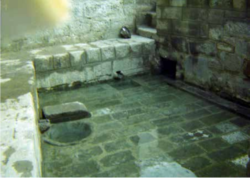
Albataş Havuzu Temizlenmiş
