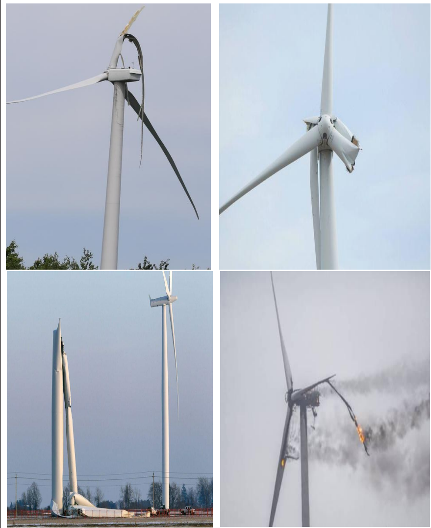
Şekil 5. Rüzgar Türbini Kanatlarında Meydana Gelen Büyük Hasarlar [21, 22, 23]
