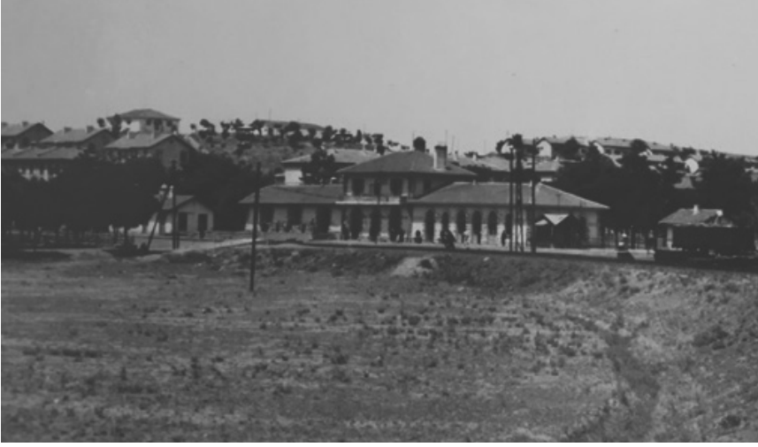
Resim 3. Kırıkkale Tren Garı, Güneyden Görünüş
